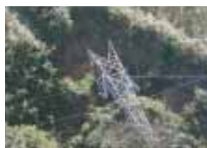
土砂崩れによる鉄塔倒壊
