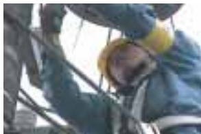
懸命な復旧作業が続けられた
