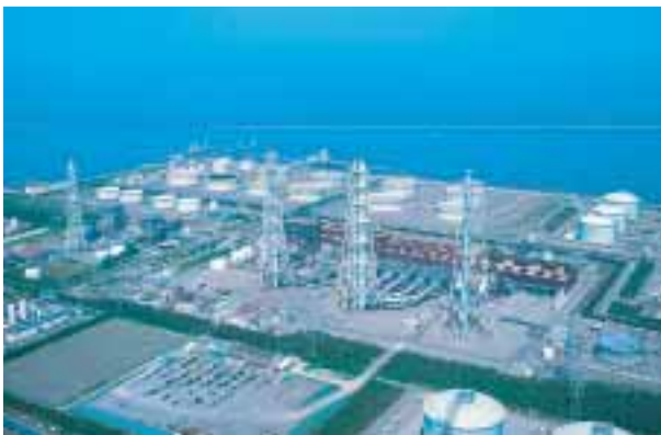
東新潟火力発電所
