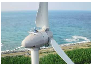
新能代風力発電所
