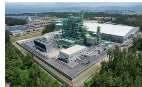
鳥海南バイオマス発電所
