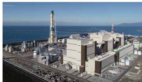
能代火力発電所におけるブラックペレット混焼に向けた検討・実証
