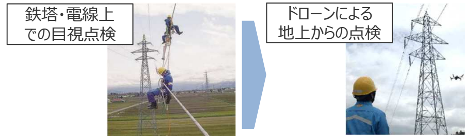
ドローンを活用した鉄塔点検の実施
