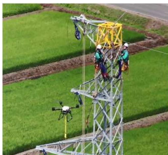
ドローンによる延線作業の様子（2021年8月）
