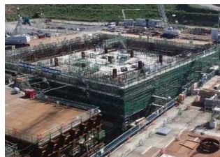
緊急時対策所 (女川：建屋躯体工事)
