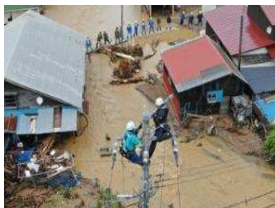
災害復旧の様子（2021年8月）
