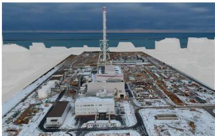
上越火力1号建設状況（2022年1月現在）
