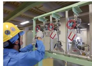
圧力容器過圧防止バルブ操作 用窒素がスポンジ交換訓練 (女川)
