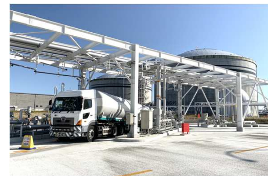
新仙台火力発電所のLNG出荷設備
