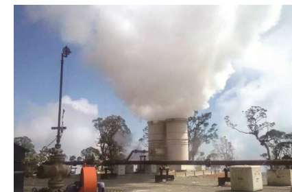
2020年後半の営業運転開始を目指し建設工事の進むランタウ・デダップ地熱発電事業
