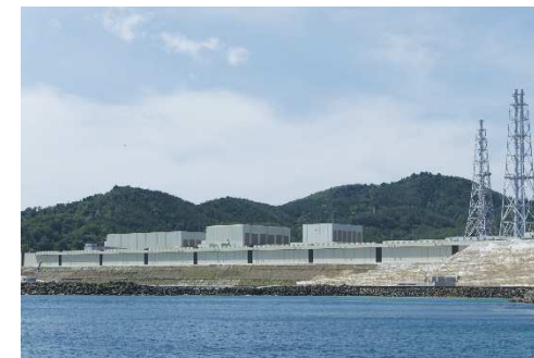
安全対策工事の進む女川原子力発電所
