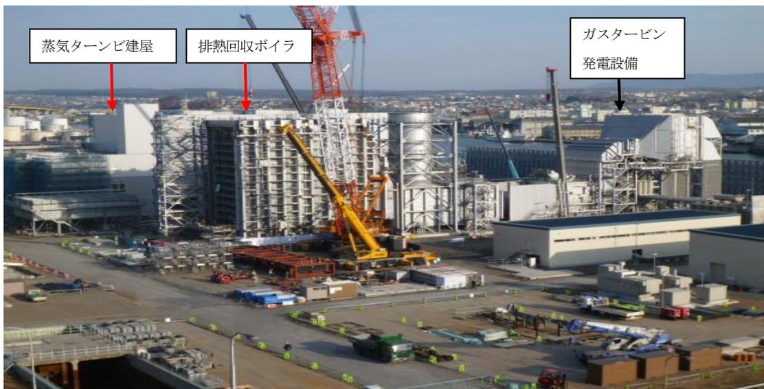
排熱回収ボイラ据付・蒸気タービン建屋工事（平成25年3月27日撮影）
