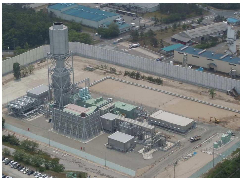
5 号機発電設備の全景
