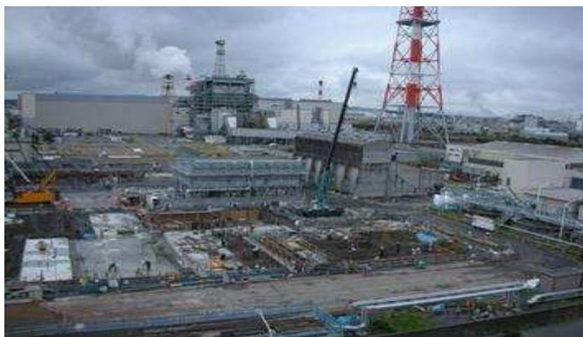
排熱回収ボイラ基礎・主要変圧器基礎工事（平成24年9月28日撮影）
