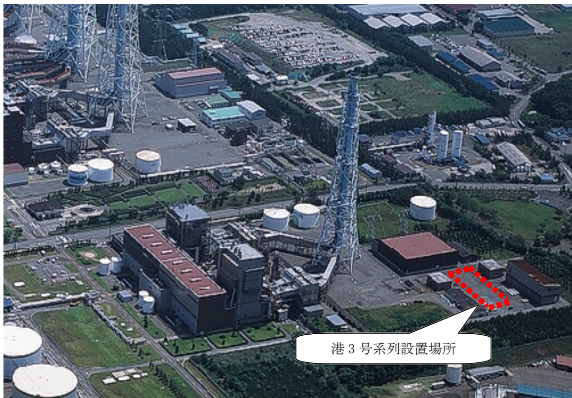
第 1 図 (3) 東新潟火力発電所の位置及びその周囲の状況
