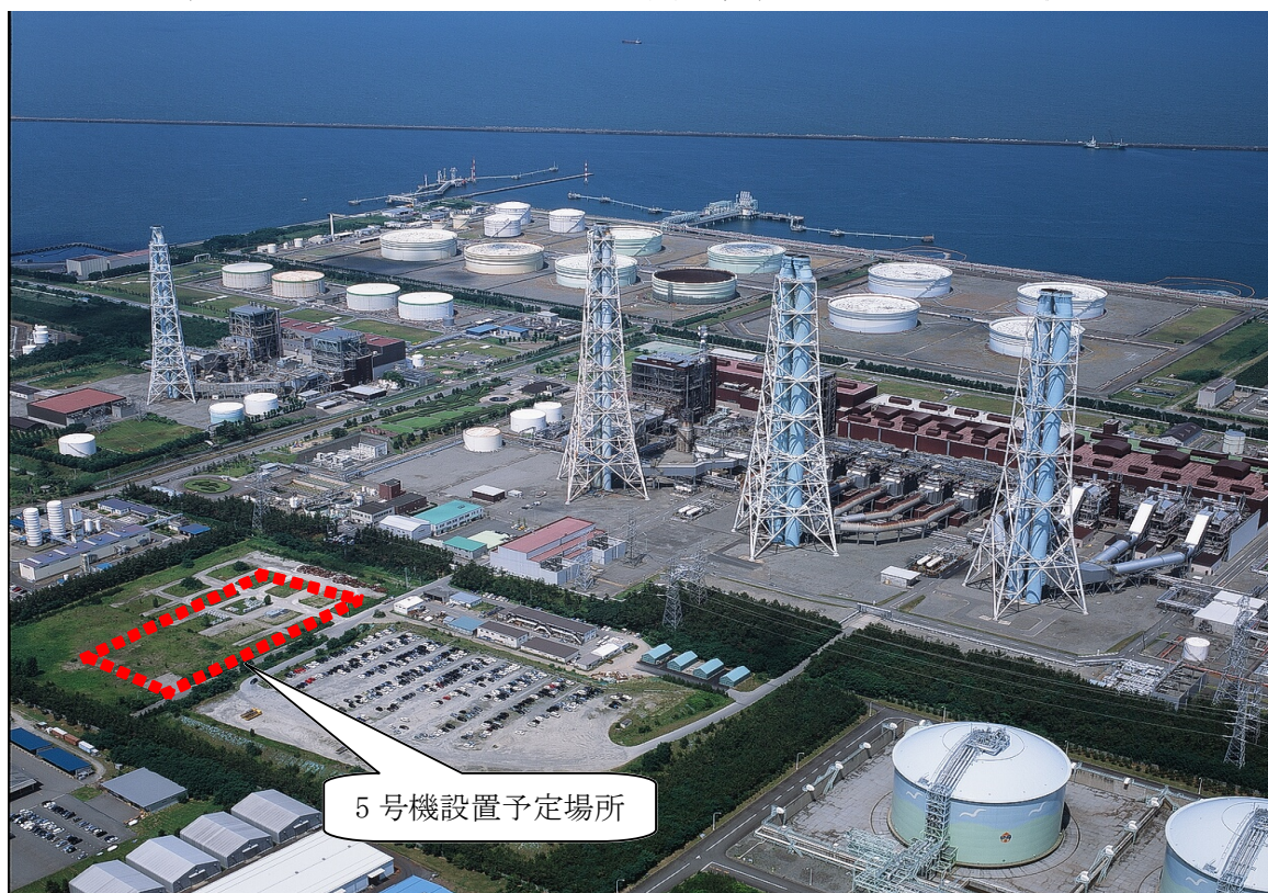
第 1 図 (2) 東新潟火力発電所の位置及びその周囲の状況
