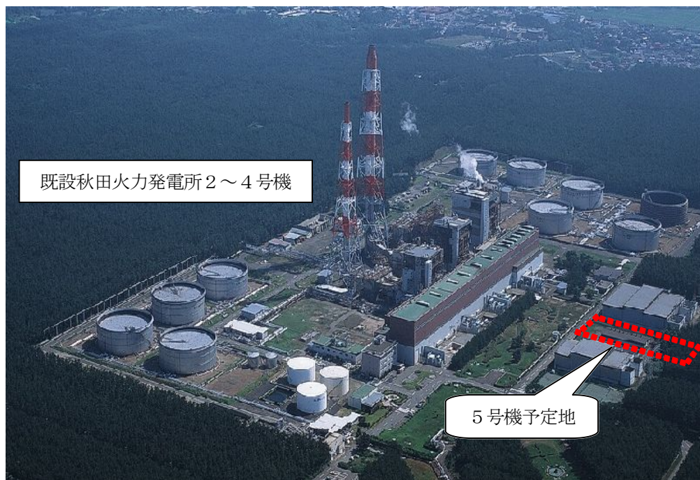
第 1 図(2) 発電所の位置及びその周囲の状況
